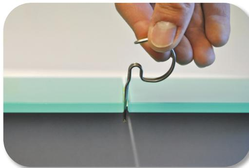
**Schritt 2:** Mit einer Drehbewegung nach links wird die Fixierkralle unter der Fliese platziert.
