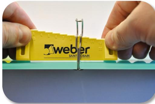
**Schritt 4:** Nachdem der Fliesenkleber abgebunden ist und eine Verfugung angestrebt wird, muss eine Demontage des Keils und der **weber Fliesen-Fixierkralle** erfolgen.
