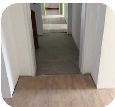
**weber.floor 4365**, der schnelltrocknende Dünnestrich, verkürzte nicht nur die Einbauzeiten gegenüber konventionellen Estrichlösungen erheblich, die Oberfläche war auch nach 2 bis 4 Stunden bereits begehbare. So traten für die Folgearbeiten kaum Verzögerungen auf. Einen weiteren Vorteil für den Bauherrn brachte die
