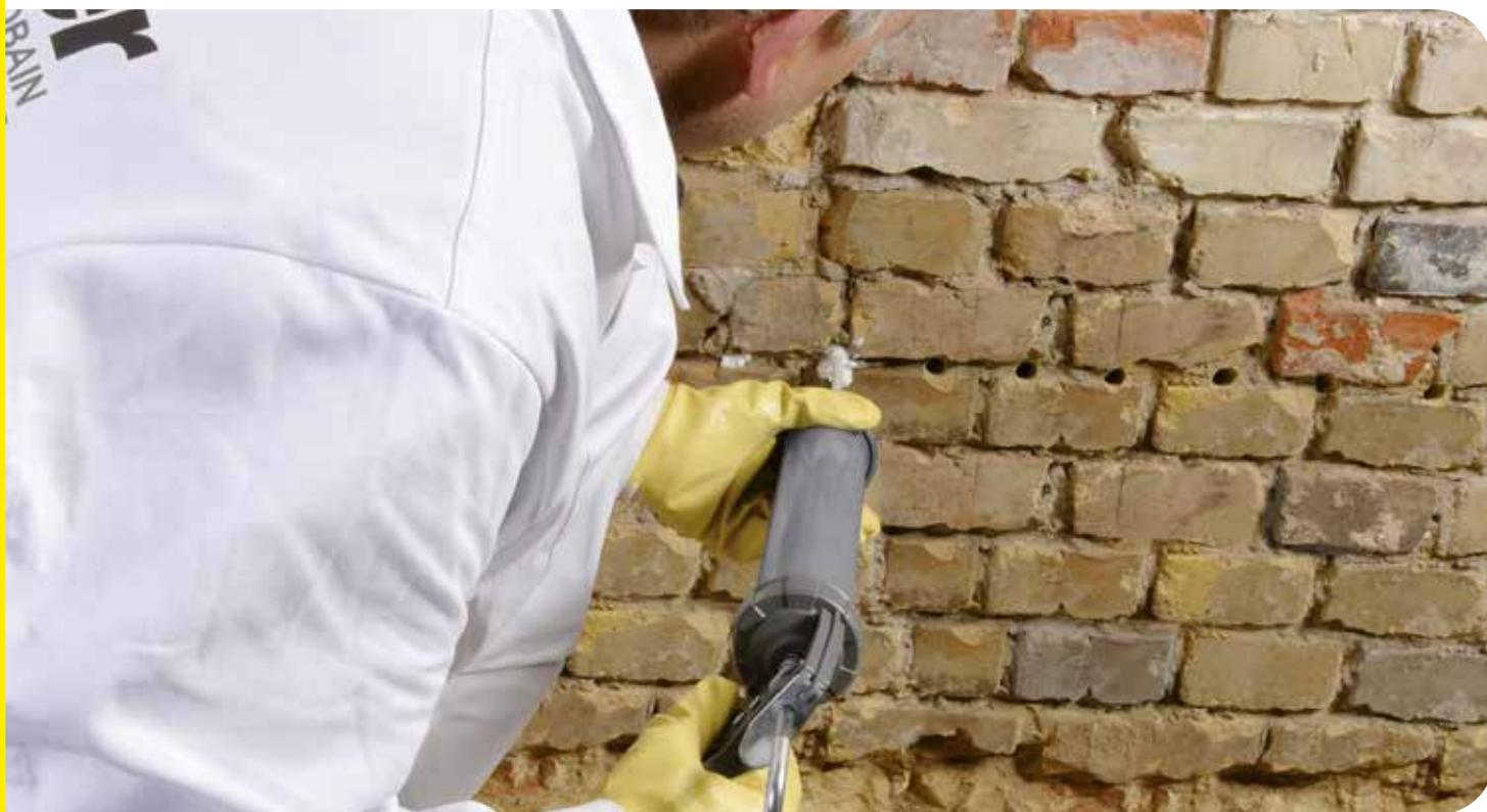
**webertec 946 ist für die nachträgliche Querschnittsabdichtung im drucklosen Bohrlochinjektionsverfahren besonders geeignet.**
