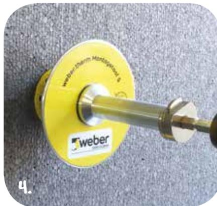
Bohrloch erstellen, Dübel einstecken, bis er auf dem Dämmstoff aufliegt. Mit dem **webertherm SRD Montagetool S** verschrauben und versenken.
