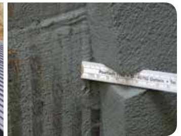
Egalisierungsspachtelung mit Sandverschnitt
