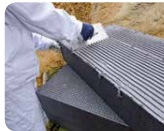
Dämmplattenverklebung
