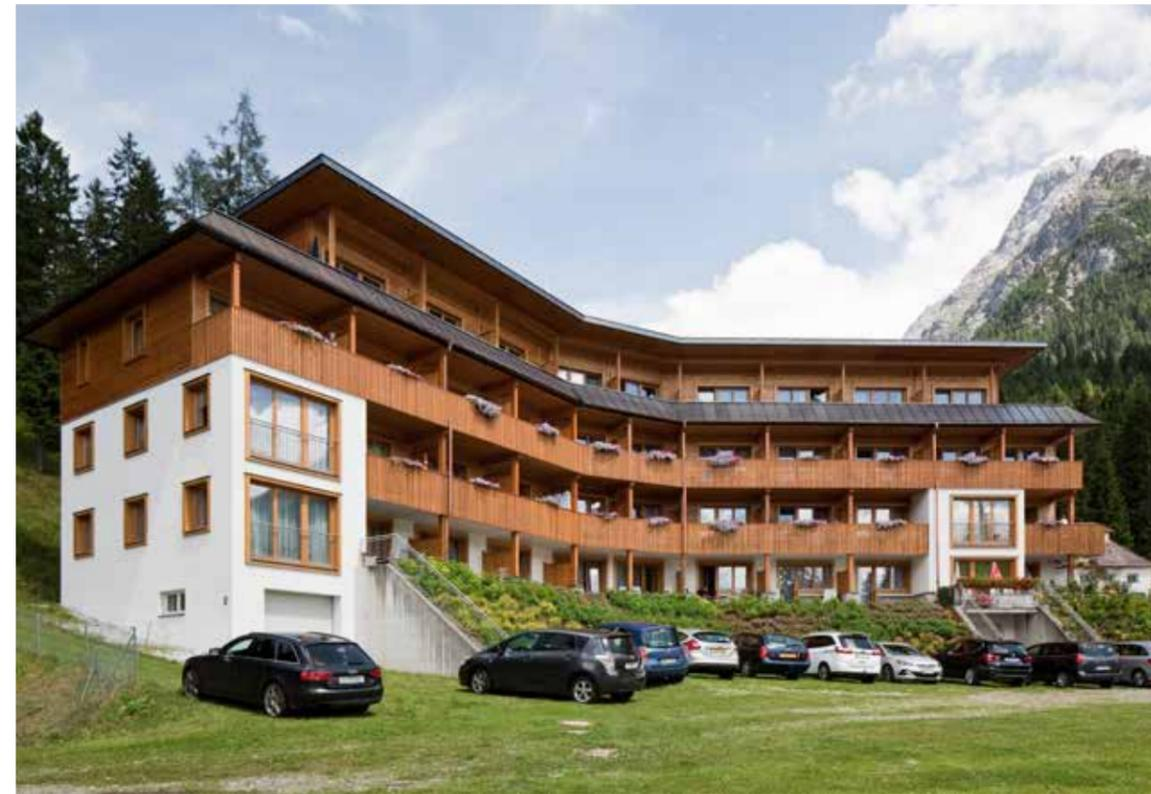
Gewichts der Konstruktion wurden zwei weitere Geschoße in Holzbauweise aufgestockt. Im Detail war die Aufstockung allerdings sehr komplex, da im Innenbereich die Lasten nur punktweise, genau auf die bestehenden Stahlbetonsäulen abgetragen werden konnten.
