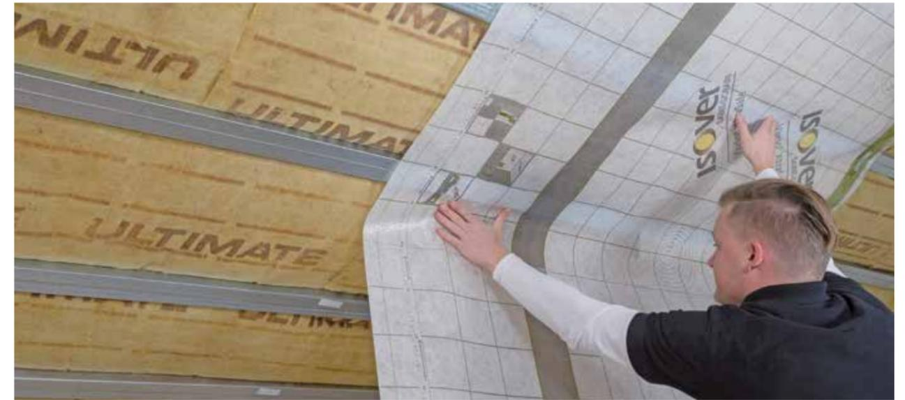
Ob Winter oder Sommer – die innovativen ISOVER Vario® Systeme für Dach und Wand sorgen für eine luftdichte Gebäudehülle in allen Holzkonstruktionen und passen sich flexibel den klimatischen Bedingungen an.
