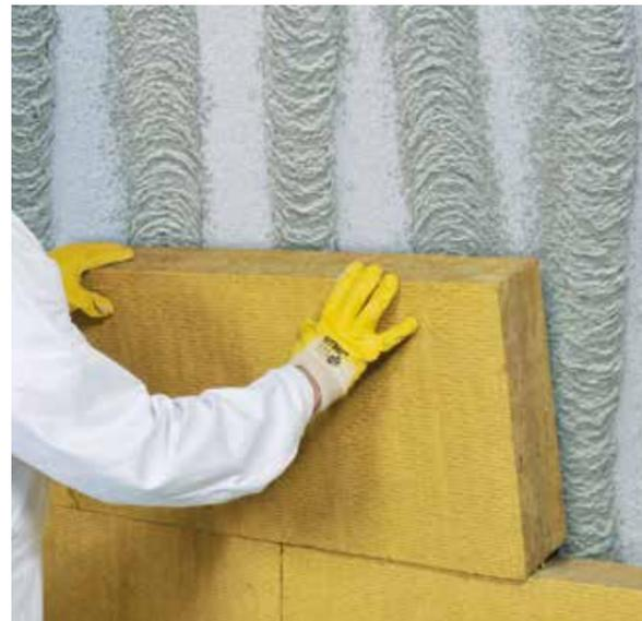
Wärmedämmverbundsysteme schützen das Gebäude vor Witterung ebenso wie vor Wärmeverlusten und sommerlicher Überhitzung. Die einzelnen **Systemkomponenten** des WDVS müssen dazu aufeinander abgestimmt sein. Teil der Europäischen Technischen Bewertung (ETB) für WDVS im Holzbau sind unter anderem:
