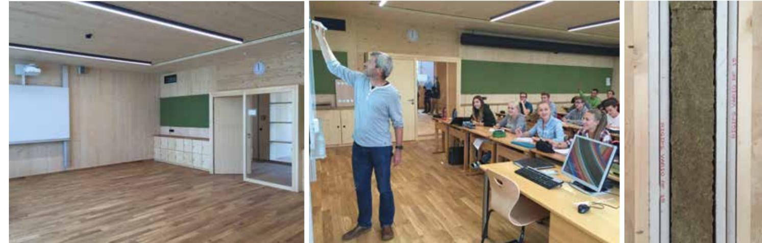
Brettsperrholz aus Fichtenholz ist der moderne Holzwerkstoff, der beim Neubau im überwiegenden Maße zum Einsatz kommt. Die kreuzweise verleimten Bretter bilden die massive Tragstruktur der Wände und Decken. „Das neue Schulgebäude wird den Anforderungen eines modernen Unterrichts vollinhaltlich gerecht.
