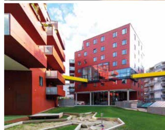
*Während alle Geschoßdecken sowie die tragenden Außenwände zum Innenhof in Stahlbeton errichtet werden, besteht die gesamte straßenseitige Fassade aus Holzriegel-elementen.*
