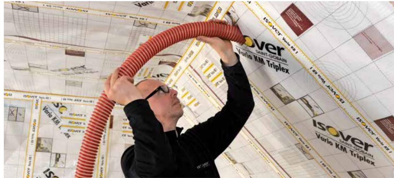
ISOVER InsulSafe Mineralwolle-Einblasdämmung aus Recyclingglas ist als „nicht brennbar, A1“ eingestuft und vereint alle Anforderungen an einen leistungsfähigen, ökologischen Dämmstoff.
