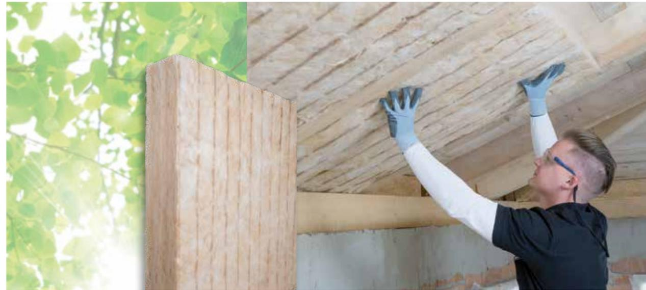
ISOVER Uniroll Plus Mineralwolle besteht aus Recyclingglas und wird mit Strom aus 100% zertifizierter Wasserkraft produziert. Sie ist gemäß ihrem Brandverhalten als „nicht brennbar“ in die höchste Euroklasse „A1“ eingestuft.
