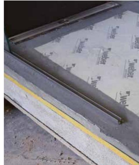
Grundsätzlich regelt die ÖNORM B 3692 die Anforderungen an die Abdichtung in Abhängigkeit der Belastungen, die in der Nutzung an das jeweilige Bauteil gestellt werden. Die individuellen Herstellungsprozesse im seriell vorgefertigten Bauen erfordern spezifische Lösungen, um diese Anforderungen zu erfüllen.
