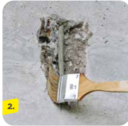
Vornässen der gesamten Ausbruchstelle
