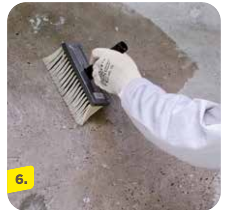
Vornässen vor Auftrag der Feinspachtelung
