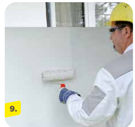
2-facher Anstrich webertec 771 auf durchgetrocknetem Feinspachtel
