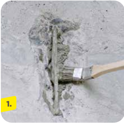
2-facher Auftrag des Korrosionsschutzes, weberrep KB duo
