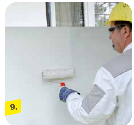
2-facher Anstrich webertec 771 auf durchgetrocknetem Feinspachtel
