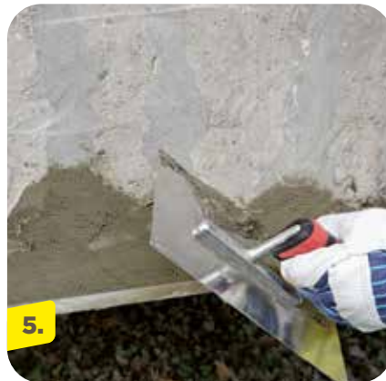
Oberfläche frisch abziehen
