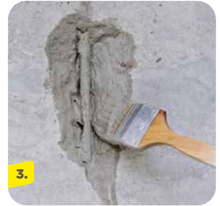
Auftrag der Haftbrücke weberrep KB duo
