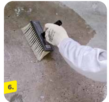
Vornässen vor Auftrag der Feinspachtelung
