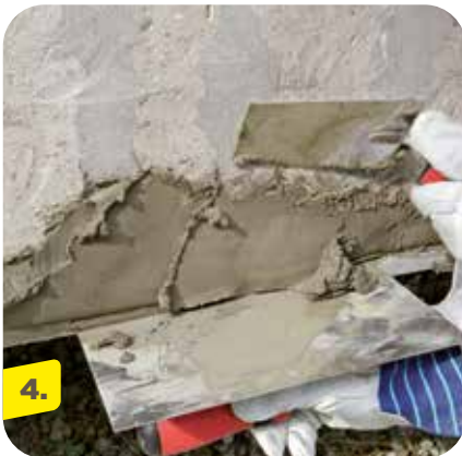
Auftrag des Betonersatzmörtels weberrep R4 duo frisch in frisch auf die Haftbrücke
