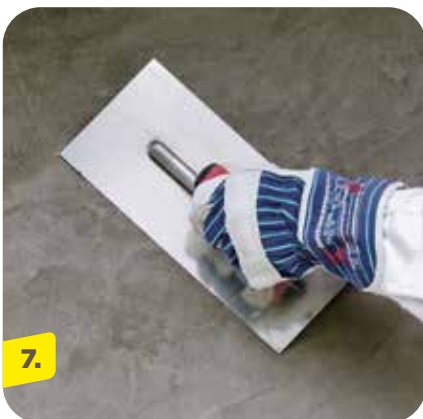
Auftrag der Feinspachtelung aus weberrep R4 duo
